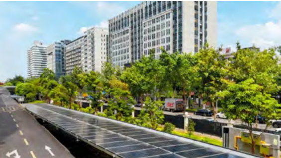
公司停车棚棚面光伏工程
